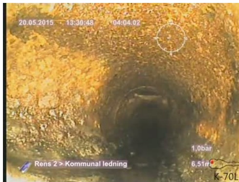
Bildnamn: 17_6_A, Videotid: 244;6440s Grenrör, klockan 09 .
