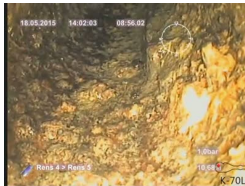
Bildnamn: 5_11_A, Videotid: 536;6428s Dimensionsförändring till 100 mm .
