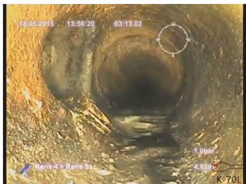
Bildnamn: 5_5_A, Videotid: 193;6428s Grenrör, klockan 09 .
