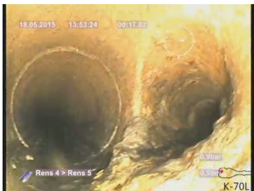
Bildnamn: 5_3_A, Videotid: 17;6428s Påbyggnad 2. Reduktion av rørets tvärsnittarea som är från 5% och upp till 15%, klockan 04-06.
