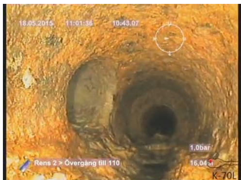
Bildnamn: 3_15_A, Videotid: 643;6426;6s Grenrör, klockan 09.
