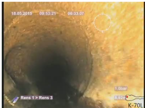
Bildnamn: 1_9_A, Videotid: 393;6424s Grenrör, klockan 09.
