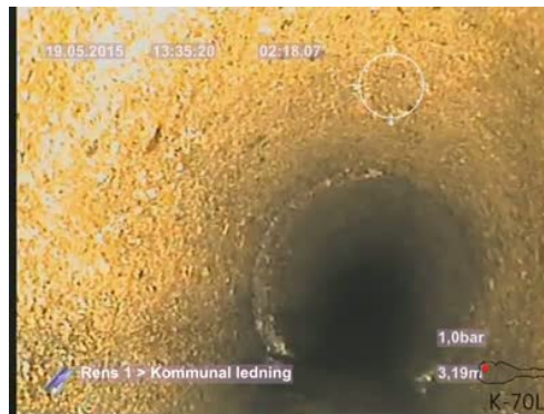
Bildnamn: 11_6_A, Videotid: 138;6434s Materialförändring till, betong .
