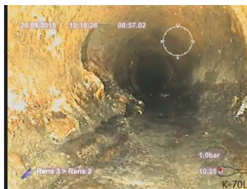
Bildnamn: 14_8_A, Videotid: 537;6437s Grenrör, klockan 10.
