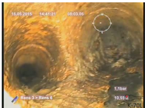
Bildnamn: 7_13_A, Videotid: 483;6430s Grenrör, klockan 09.
