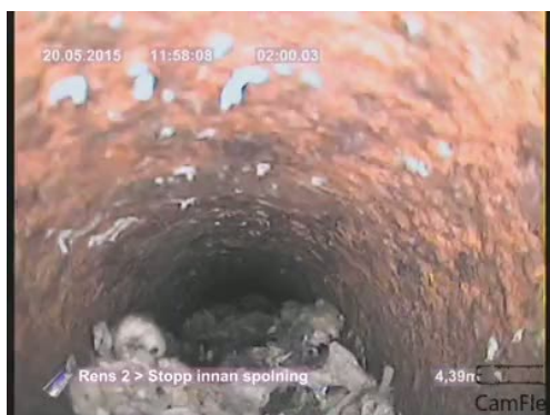
Bildnamn: 15_3_A, Videotid: 120;6438s Främmande föremål 4. Reduktion av rörets tvärsnittsarea som är från 30 % eller större.
