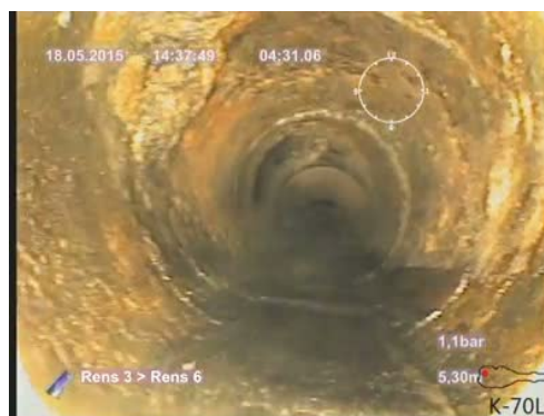
Bildnamn: 7_8_A, Videotid: 271;6430s Påbyggnad 2. Reduktion av rörets tvärsnittsarea som är från 5% och upp till 15%, klockan 11.
