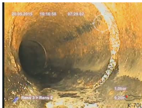
Bildnamn: 14_6_A, Videotid: 449;6437s Böjd rördel, klockan 09, vänster.
