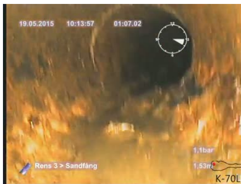
Bildnamn: 8_4_A, Videotid: 67;6431s Böjd rördel, klockan 03, höger.
