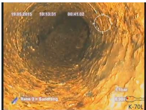
Bildnamn: 8_3_A, Videotid: 41;6431s Ytskada 2. Rörväggen är synligt påverkad med ökad ytråhet som följd, klockan 12-12, börjar.
