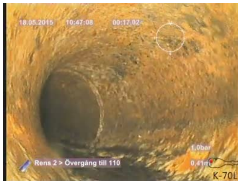
Bildnamn: 3_2_A, Videotid: 17;6426s Böjd rördel, klockan 09, vänster.
