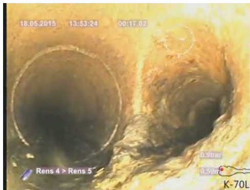
Bildnamn: 5_2_A, Videotid: 17;6428s Grenrör, klockan 03.
