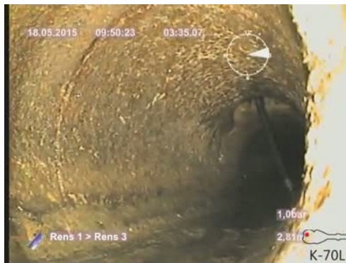
Bildnamn: 1_6_A, Videotid: 215;6424;6s Grenrör, klockan 03.
