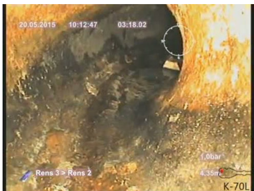
Bildnamn: 14_3_A, Videotid: 198;6437s Böjd rördel, klockan 03, höger.
