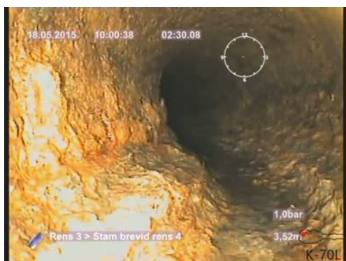
Bildnamn: 2_7_A, Videotid: 150;6425s Böjd rördel, klockan 09 , vänster .
