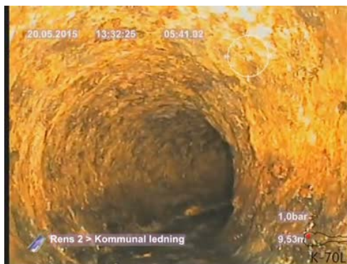
Bildnamn: 17_8_A, Videotid: 341;6440s Böjd rördel, klockan 03 , höger .
