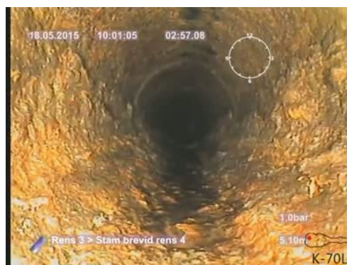
Bildnamn: 2_9_A, Videotid: 177;6425s Påbyggnad 2. Reduktion av rörets tvärsnittsarea som är från 5% och upp till 15%.
