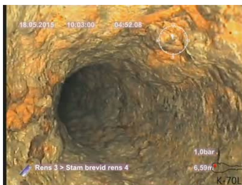
Bildnamn: 2_13_A, Videotid: 292;6425s Dimensionsförändring till 100 mm.
