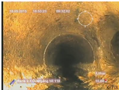
Bildnamn: 3_10_A, Videotid: 392;6426s Grenrör, klockan 03 .
