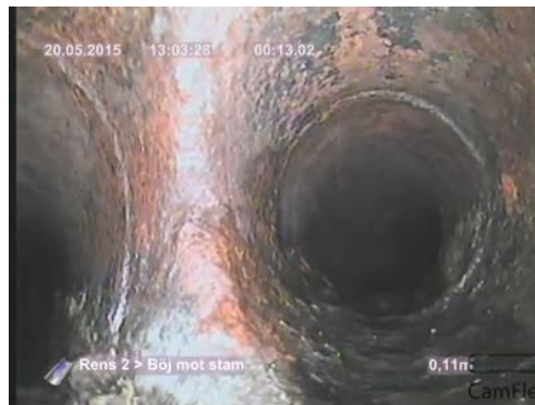
Bildnamn: 16_2_A, Videotid: 13;6439s Grenrör, klockan 03.
