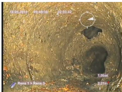
Bildnamn: 1_4_A, Videotid: 123;6424;6s Påbyggnad 3. Reduktion av rörets tvärsnittsarea som är från 15% och upp till 30%, klockan 02-09 .
