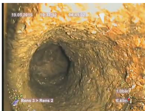
Bildnamn: 9_4_A, Videotid: 281;6432s Grenrör, klockan 12.
