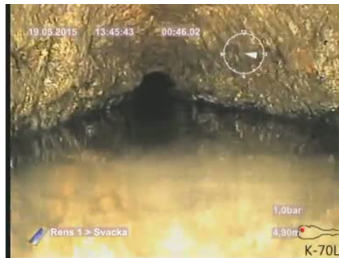
Bildnamn: 12_2_A, Videotid: 46;6435s Svacka / Upphöjning 3: Allvarliga driftstörningar.
