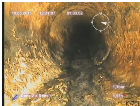
Bildnamn: 10_3_A, Videotid: 63;6433s Påbyggnad 2. Reduktion av rörets tvärsnittsarea som är från 5% och upp till 15%.
