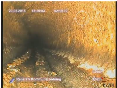
Bildnamn: 17_5_A, Videotid: 139;6440s Påbyggnad 2. Reduktion av rörets tvärsnittsarea som är från 5% och upp till 15%, klockan 05-07 .
