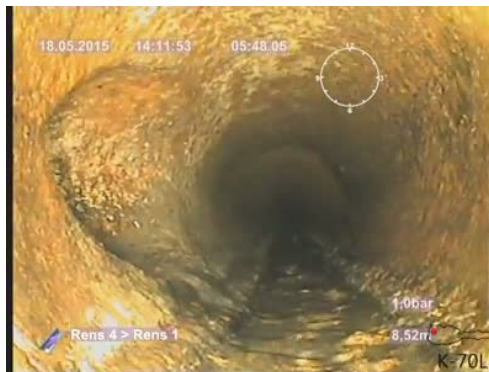
Bildnamn: 6_10_A, Videotid: 348;6429s Grenrör, klockan 09.
