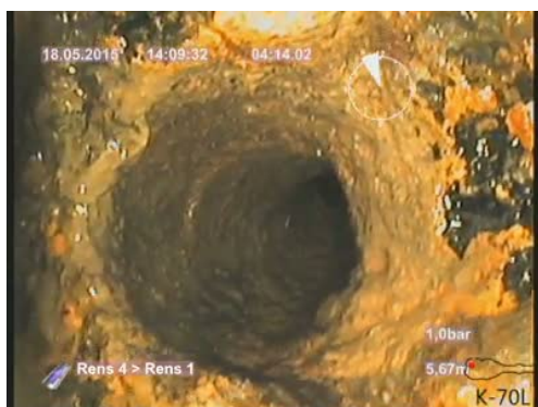
Bildnamn: 6_7_A, Videotid: 254;6429s Grenrör, klockan 12.
