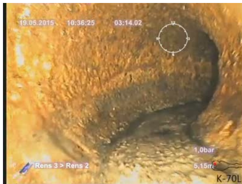
Bildnamn: 9_2_A, Videotid: 194;6432;6s Böjd rördel, klockan 03, s-form (essning).
