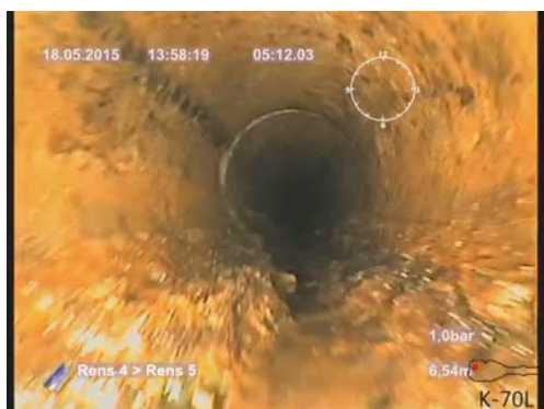
Bildnamn: 5_7_A, Videotid: 312;6428s Påbyggnad 3. Reduktion av rörets tvärsnittsarea som är från 15% och upp till 30%, klockan 03-09, börjar .
