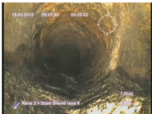
Bildnamn: 2_3_A, Videotid: 20;6425s Grenrör, klockan 03.
