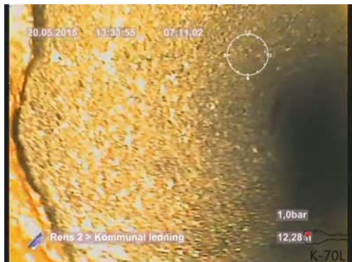
Bildnamn: 17_9_A, Videotid: 431;6440s Materialförändring till, betong .
