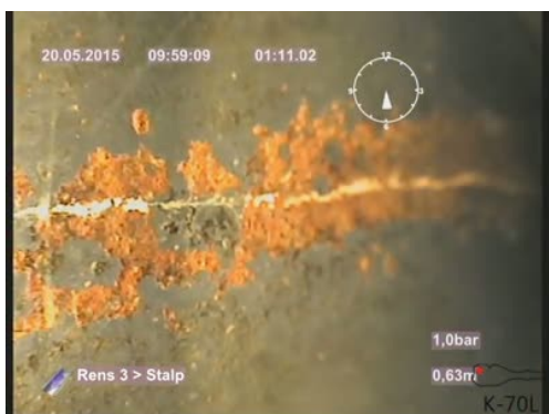
Bildnamn: 13_3_A, Videotid: 71;6436s Sprickor 2. Ej öppen spricka, klockan 03,09, längsgående.
