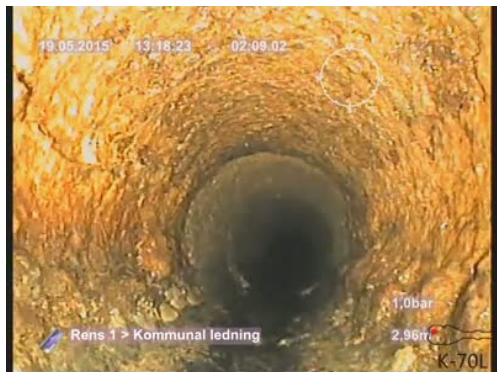
Bildnamn: 11_5_A, Videotid: 129;6434s Påbyggnad 2. Reduktion av rörets tvärsnittsarea som är från 5% och upp till 15%.
