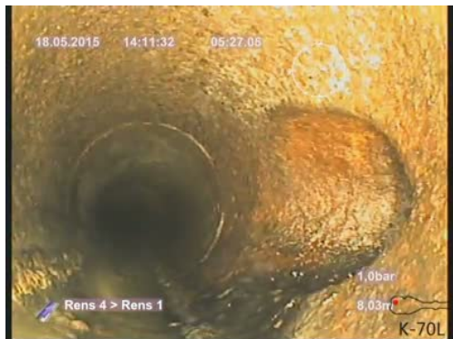
Bildnamn: 6_9_A, Videotid: 327;6429s Grenrör, klockan 03.
