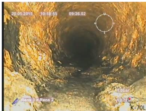
Bildnamn: 14_10_A, Videotid: 566;6437s Grenrör, klockan 11 .
