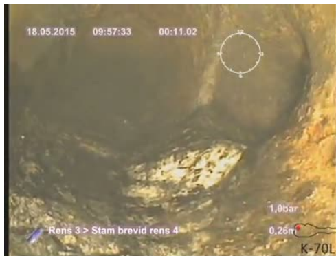
Bildnamn: 2_2_A, Videotid: 11;6425s Påbyggnad 2. Reduktion av rörets tvärsnittsarea som är från 5% och upp till 15%, klockan 03-06.
