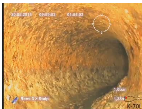
Bildnamn: 13_4_A, Videotid: 114;6436s Böjd rördel, klockan 03, höger.
