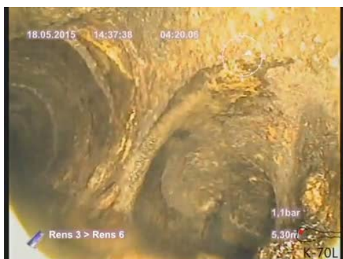
Bildnamn: 7_7_A, Videotid: 260;6430s Påbyggnad 2. Reduktion av rörets tvärsnittsarea som är från 5% och upp till 15%, klockan 04-05.
