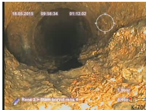
Bildnamn: 2_6_A, Videotid: 72;6425s Grenrör, klockan 09 .
