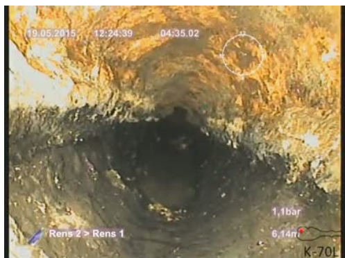
Bildnamn: 10_8_A, Videotid: 275;6433s Påbyggnad 3. Reduktion av rörets tvärsnittsarea som är från 15% och upp till 30%.
