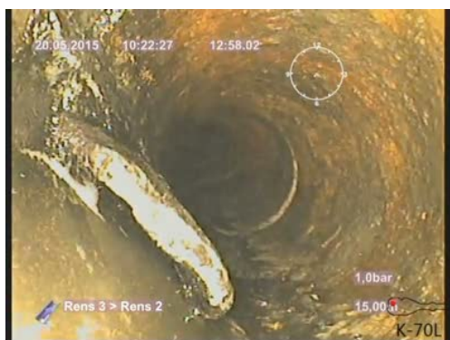
Bildnamn: 14_15_A, Videotid: 778;6437s Främmande föremål 3. Reduktion av rörets tvärsnittsarea som är från 15 % och upp till 30 %.
