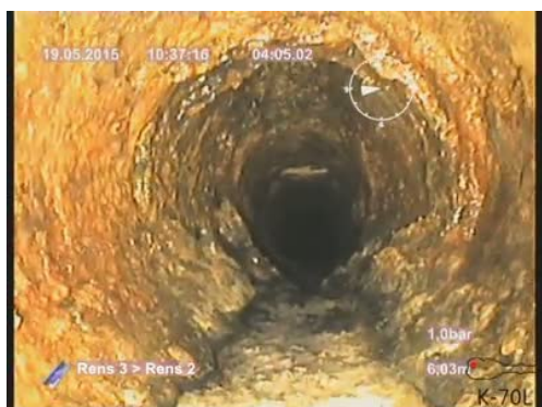
Bildnamn: 9_3_A, Videotid: 245;6432s Påbyggnad 3. Reduktion av rörets tvärsnittsarea som är från 15% och upp till 30%, klockan 03-09.
