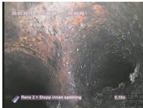
Bildnamn: 15_2_A, Videotid: 42;6438s Grenrör, klockan 03.
