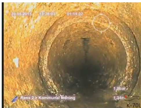
Bildnamn: 17_4_A, Videotid: 79;6440s Fogförskjutning 3. Radiell fogförskjutning där knappt rörets hela godstjocklek är synlig.
