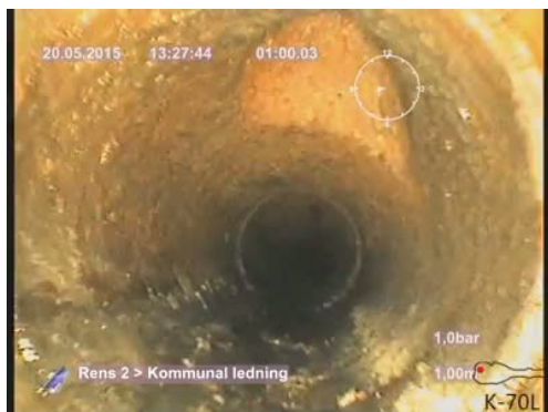
Bildnamn: 17_3_A, Videotid: 60;6440s Grenrör, klockan 12.
