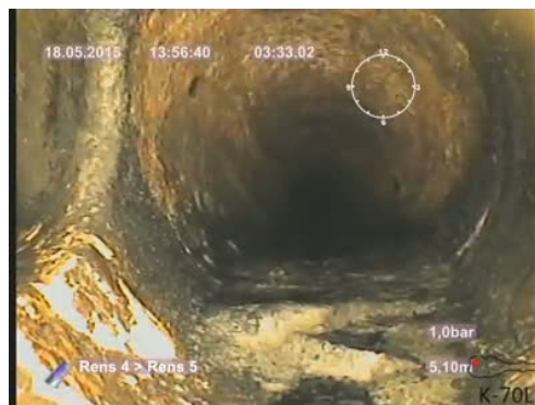
Bildnamn: 5_6_A, Videotid: 213;6428s Påbyggnad 2. Reduktion av rörets tvärsnittsarea som är från 5% och upp till 15%, klockan 04-07 .
