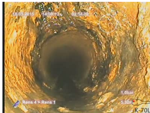
Bildnamn: 6_6_A, Videotid: 234;6429s Påbyggnad 2. Reduktion av rörets tvärsnittsarea som är från 5% och upp till 15%.
