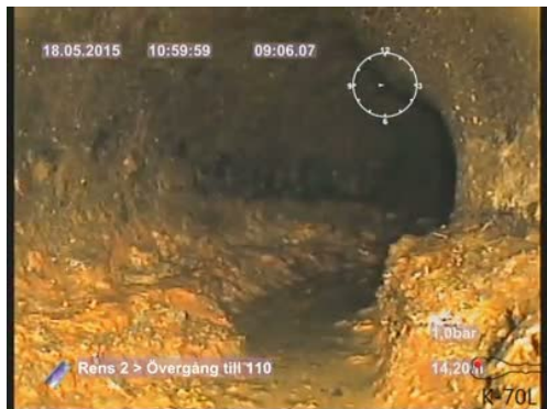
Bildnamn: 3_13_A, Videotid: 546;6426s Böjd rördel, klockan 03, höger.
