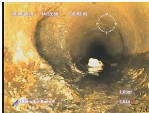
Bildnamn: 7_2_A, Videotid: 173;6430s Påbyggnad 2. Reduktion av rörets tvärsnittsarea som är från 5% och upp till 15%, klockan 07 .
