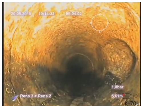
Bildnamn: 14_5_A, Videotid: 304;6437s Grenrör, klockan 03.
