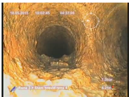
Bildnamn: 2_12_A, Videotid: 277;6425s Påbyggnad 3. Reduktion av rörets tvärsnittsarea som är från 15% och upp till 30%, klockan 03-09.
