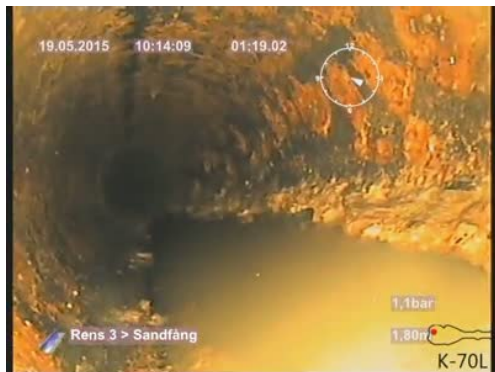
Bildnamn: 8_5_A, Videotid: 79;6431s Påbyggnad 2. Reduktion av rörets tvärsnittsarea som är från 5% och upp till 15%, börjar.
