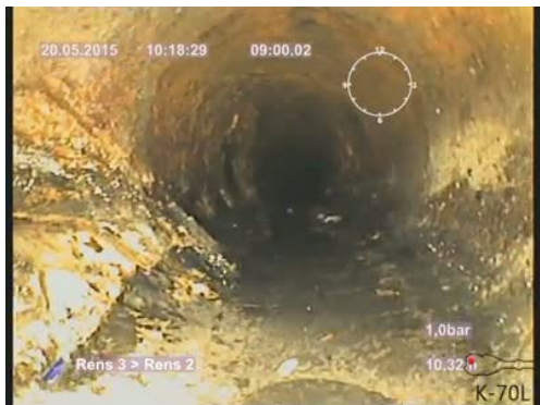
Bildnamn: 14_9_A, Videotid: 540;6437s Påbyggnad 2. Reduktion av rörets tvärsnittsarea som är från 5% och upp till 15%.
