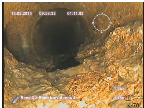
Bildnamn: 2_5_A, Videotid: 71;6425;64s Påbyggnad 3. Reduktion av rörets tvärsnittsarea som är från 15% och upp till 30%, klockan 02-09 , börjar .
