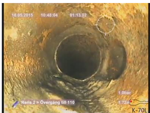
Bildnamn: 3_3_A, Videotid: 73;6426s Grenrör, klockan 03.
