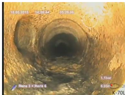
Bildnamn: 7_10_A, Videotid: 326;6430s Grenrör, klockan 10.
