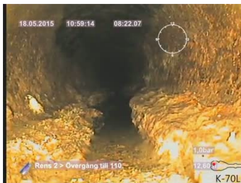
Bildnamn: 3_12_A, Videotid: 502;6426;6s Påbyggnad 3. Reduktion av rörets tvärsnittsarea som är från 15% och upp till 30%, klockan 03-09, börjar .
