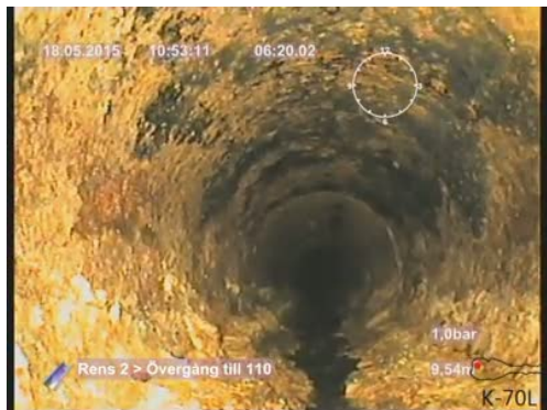
Bildnamn: 3_9_A, Videotid: 380;6426s Påbyggnad 2. Reduktion av rörets tvärsnittsarea som är från 5% och upp till 15%.
