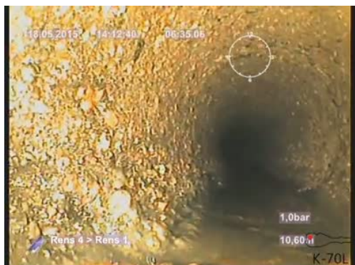
Bildnamn: 6_11_A, Videotid: 395;6429s Materialförändring till, betong.
