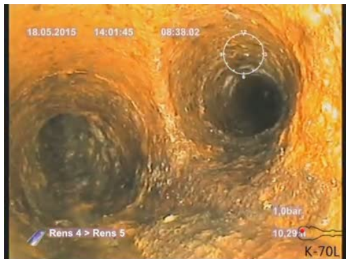
Bildnamn: 5_9_A, Videotid: 518;6428s Grenrör, klockan 03 .
