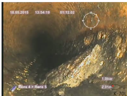
Bildnamn: 5_4_A, Videotid: 72;6428s Främmande föremål 2. Reduktion av rørets tvärsnittarea som är från 5 % och upp till 15 %.
