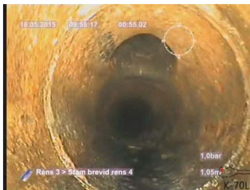
Bildnamn: 2_4_A, Videotid: 55;6425s Grenrör, klockan 12.
