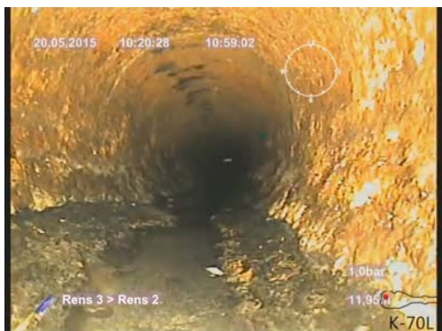
Bildnamn: 14_11_A, Videotid: 659;6437s Böjd rördel, klockan 03 , höger .
