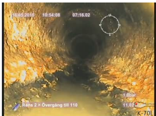
Bildnamn: 3_11_A, Videotid: 436;6426s Påbyggnad 2. Reduktion av rörets tvärsnittsarea som är från 5% och upp till 15%, klockan 03-09 .
