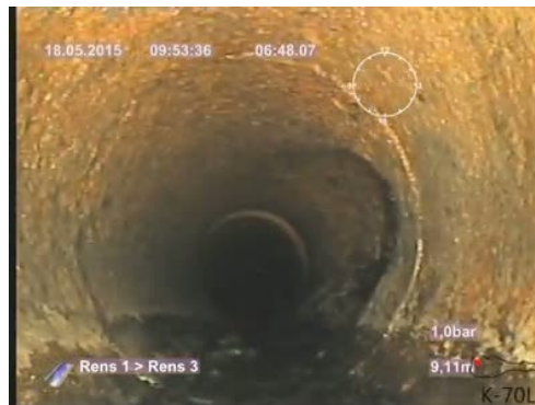
Bildnamn: 1_10_A, Videotid: 408;6424s Grenrör, klockan 03.
