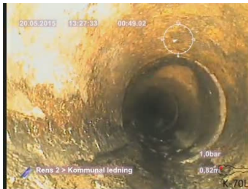
Bildnamn: 17_2_A, Videotid: 49;6440s Böjd rördel, klockan 09, vänster.
