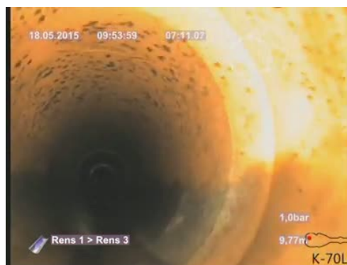
Bildnamn: 1_12_A, Videotid: 431;6424s Materialförändring till, pp.
