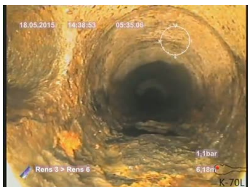
Bildnamn: 7_11_A, Videotid: 335;6430;6s Påbyggnad 3. Reduktion av rörets tvärsnittsarea som är från 15% och upp till 30%, klockan 04-08, börjar.
