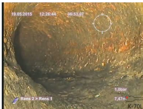
Bildnamn: 10_9_A, Videotid: 373;6433s Böjd rördel, klockan 09 , vänster .
