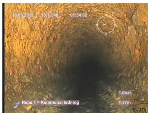
Bildnamn: 11_4_A, Videotid: 94;6434s Ytskada 2. Rörväggen är synligt påverkad med ökad ytråhet som följd.
