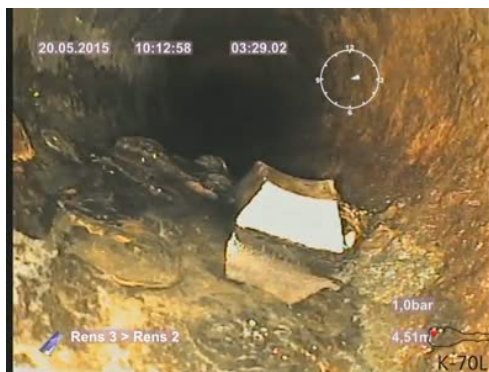
Bildnamn: 14_4_A, Videotid: 209;6437s Främmande föremål 3. Reduktion av rörets tvärsnittsarea som är från 15 % och upp till 30 %.
