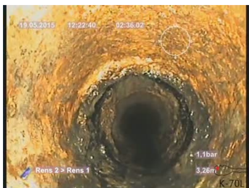
Bildnamn: 10_4_A, Videotid: 156;6433s Påbyggnad 2. Reduktion av rörets tvärsnittsarea som är från 5% och upp till 15%.
