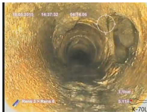
Bildnamn: 7_6_A, Videotid: 254;6430s Grenrör, klockan 02.
