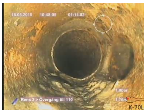
Bildnamn: 3_4_A, Videotid: 74;6426s Påbyggnad 2. Reduktion av rørets tvärsnittsarea som är från 5% och upp till 15%, klockan 04-08.
