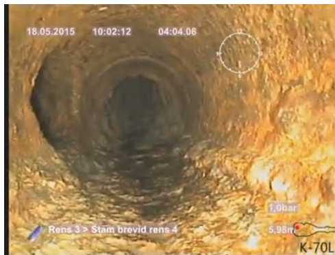
Bildnamn: 2_11_A, Videotid: 244;6425s Grenrör, klockan 09.
