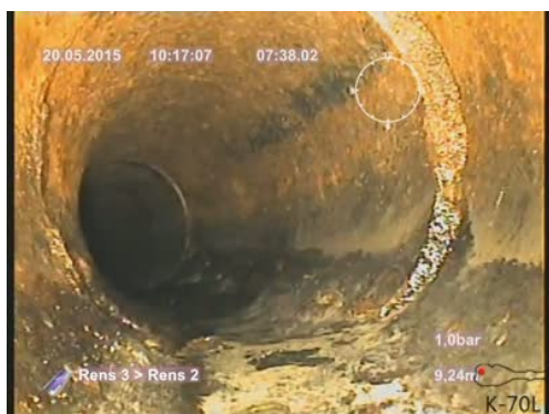
Bildnamn: 14_7_A, Videotid: 458;6437s Fogförskjutning 3. Radiell fogförskjutning där knappt rörets hela godstjocklek är synlig.
