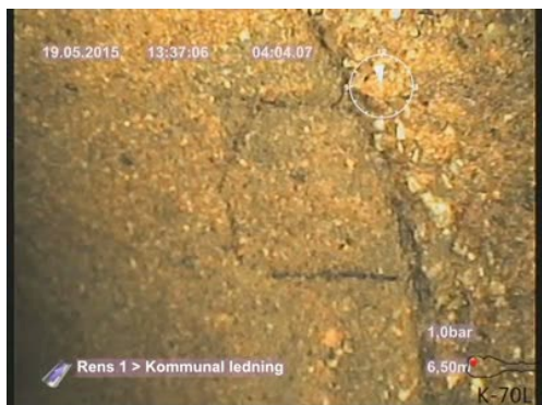
Bildnamn: 11_7_A, Videotid: 244;6434s Sprickor 2. Ej öppen spricka, klockan 12 , utspridda .
